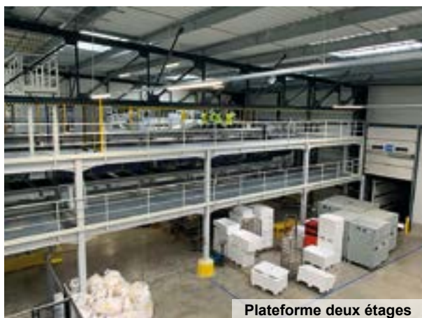
Plateforme deux étages
