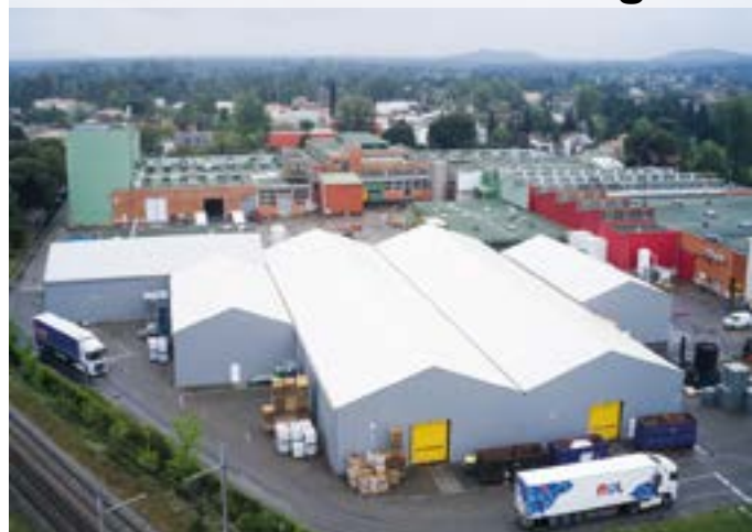
Toiture toile et bardage
