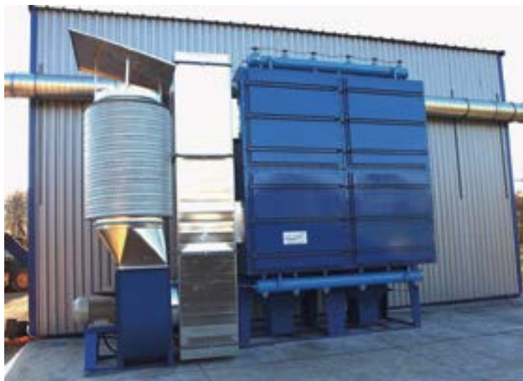
Dépoussiéreur à cartouche à décolmatage pneumatique
