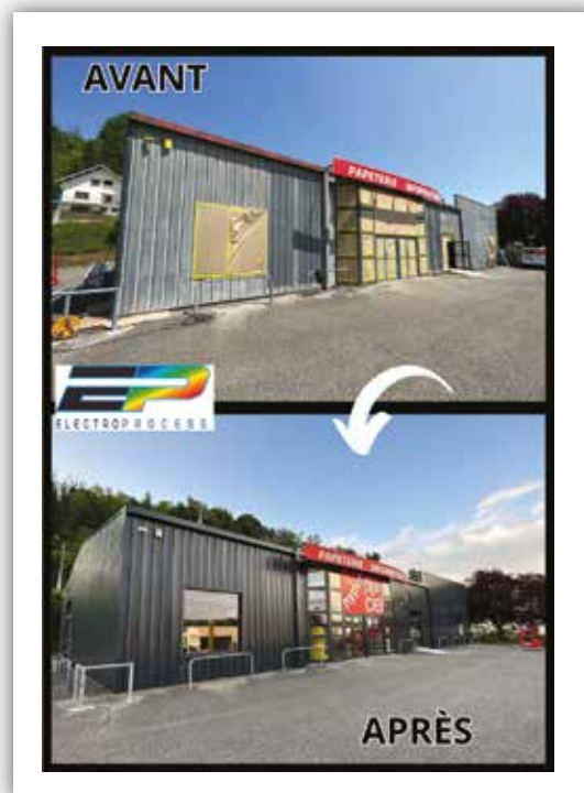
Rénovation Bardage Plein Ciel.
