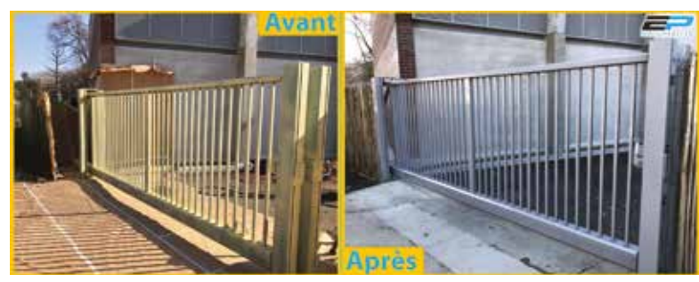
Préparation et mise en peinture d'un portail.
