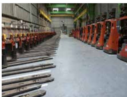
Résine époxy antidérapante et anticorrosion Local charge batteries en logistique
