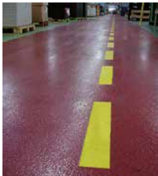
Résine polyuréthane-ciment autolissante Salle blanche d'embouteillage
