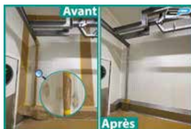
Masticage et ponçage puis préparation et mise en peinture de panneaux en intérieur.
