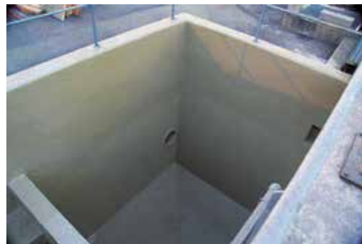
Résine polyurée anticorrosion projetée à chaud Fosse de station de traitement d'eau industrielle
