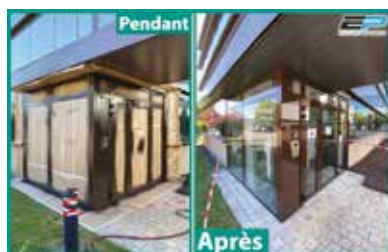
Préparation et mise en peinture des huisseries.
