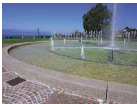
Etanchéité en résine polyurée Bassin d'agrément sur parking public
