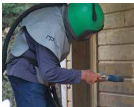
Décapage d'un chalet en bois
