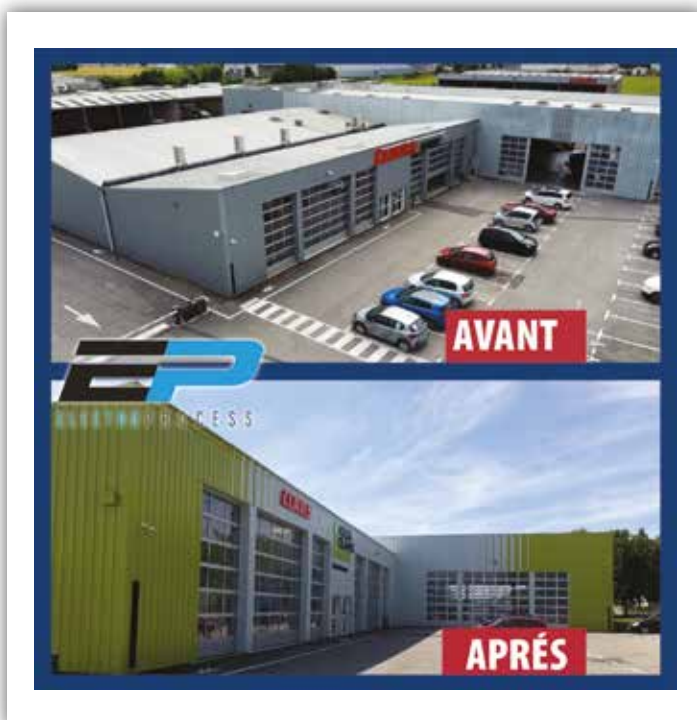
Rénovation Bardage CLAAS.
