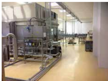
Résine polyuréthane-ciment autolissante Salle blanche d'embouteillage
